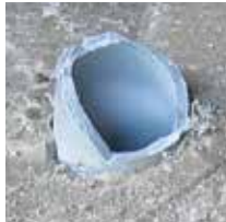
Broken conduit on jobsite
